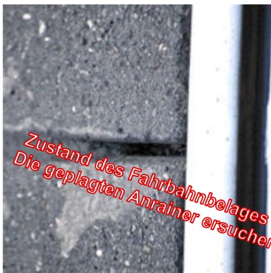
**Lärmintensive Reifenabrollgeräusche durch lärmverstärkenden Beton-Straßenbelag**
